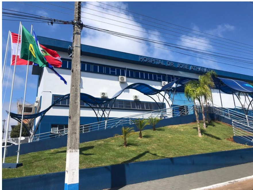
Figura 02: Vista Frontal do Hospital
